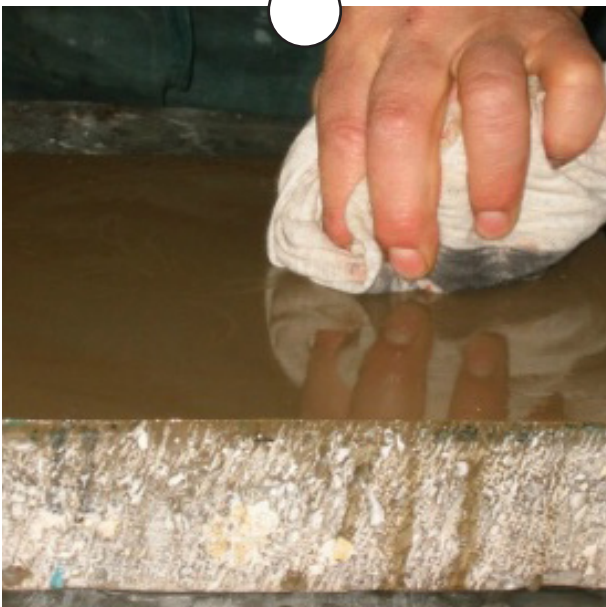
Humidification de la pierre avec de l'eau
